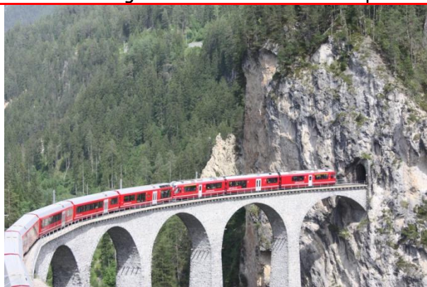
Le viaduc de la Landwasser
