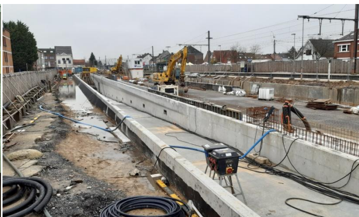
Accès en rampe au nouveau couloir sous-voie à Waterloo
