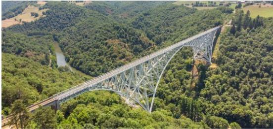
L'utilisation du béton et du métal va remplacer la maçonnerie avec l'apparition des ponts en arc avec tablier. Des ingénieurs ont remarqué qu'en intégrant du béton dans des tubes en acier, on obtenait une meilleure résistance. Le pont Liantuo en Chine a inauguré cette technique en 1990. Les tabliers seront posés tantôt sur l'arc comme celui de Viaur en Aveyron (ci-contre) tantôt suspendus.
